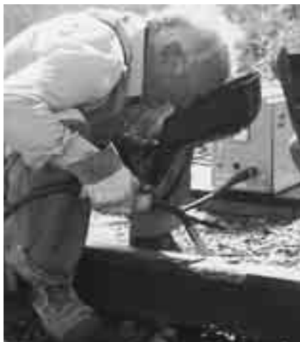
Wheel burn repair OK Tubrodur 15.43.
